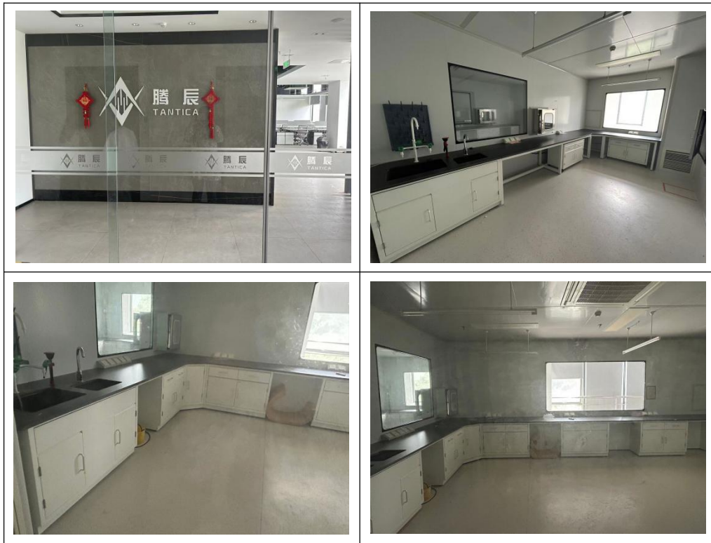
图 2-5 本项目拟建区现状照片
